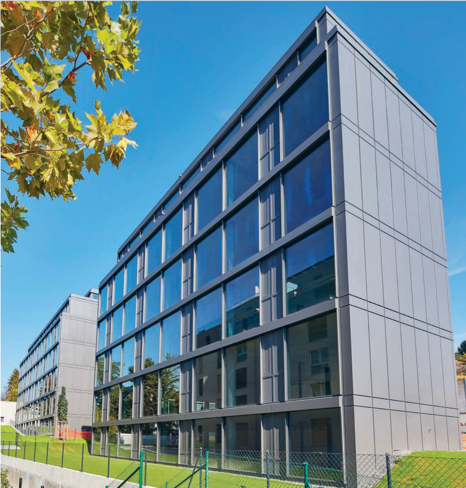
Das Gebäude erfüllt den Minergie-Standard und ist mit Recycling-Beton gebaut. Le bâtiment répond à la norme Minergie et est construit avec du béton recyclé.
