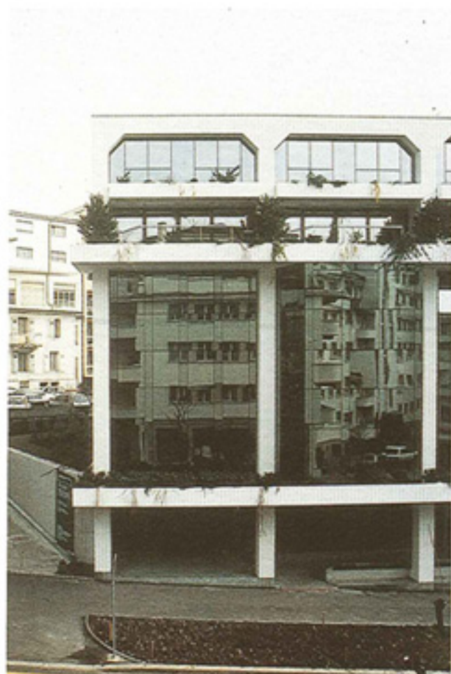
■ Vista della parte terminale a nord. ■ View of the north end.
