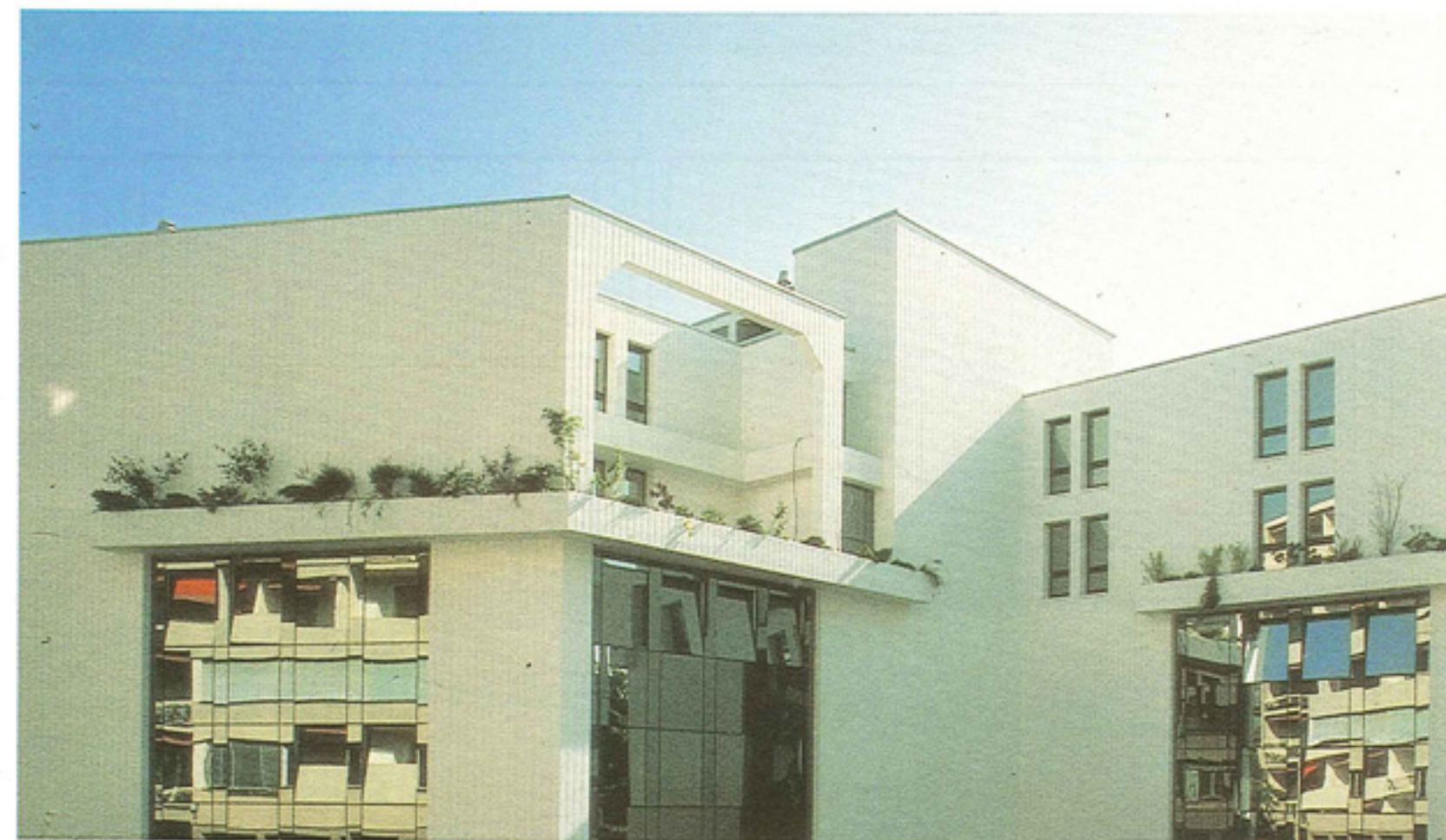
■ Veduta dalla corte interna. ■ View from the interior courtyard.
