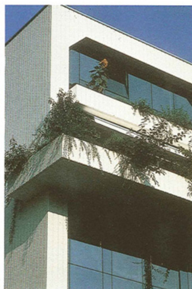
■ Dettaglio della testata nord. ■ Detail of the north end.
